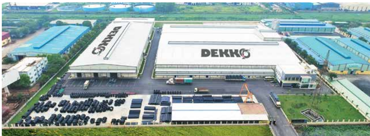
Nhà máy số 1: Tại Km23+700 Quốc lộ 5, xã Di Sơn, huyện Mỹ Hào, Tỉnh Hưng Yên Factory 1: Km23+700 National Highway 5, Di Su Commune, My Hao District, Hung Yen Province
