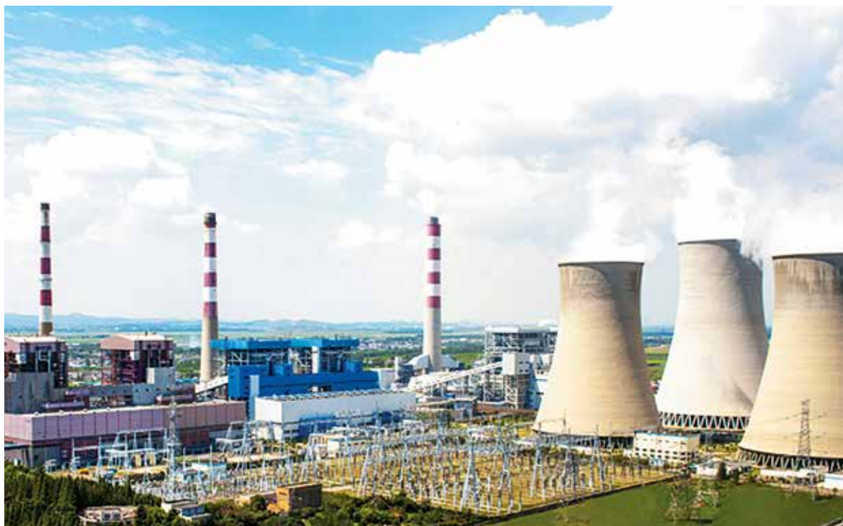
NHÀ MÁY NHIỆT ĐIỆN NGHI SƠN – THANH HÓA THE NGHI SON THERMAL POWER PLANT - THANH HOA PROVINCE
